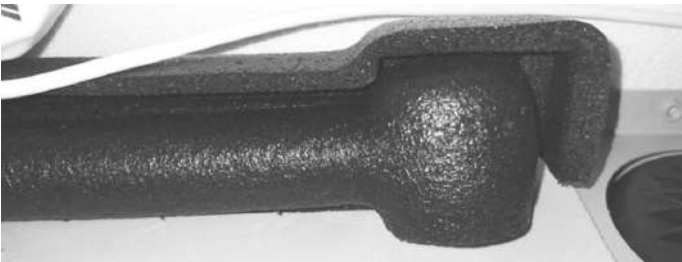
Posizionare il guscio (2a) in modo che copra l'intero tubo e si infili nel guscio (2b).
