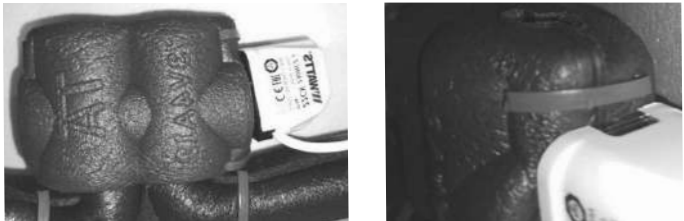
Posizionare il guscio (1) attorno al corpo valvola e chiuderlo nella parte superiore con due graffette (4).
