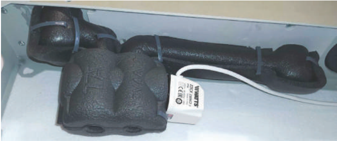
Una volta completati i passaggi precedenti, assicurarsi che non siano presenti parti scoperte che potrebbero provocare la formazione di condensa e il gocciolamento.
